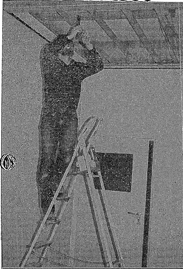
Jugendleiter Georg Spengler bei der Arbeit: In den Räumen der Jugendtagé in der Buschschule werden Holzdecken eingezogen.
